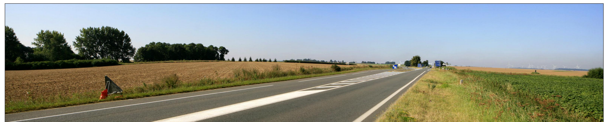
Vue du site avant projet
